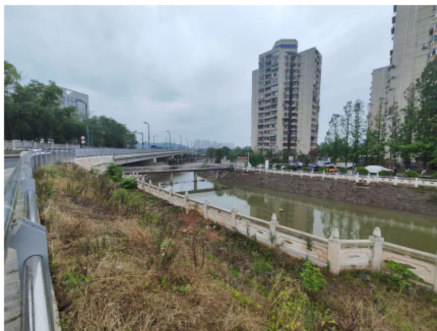
图 2-6 项目 K0+130 拟拆除固定堰现状图
