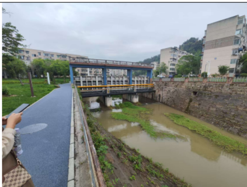
图 2-7 项目 K0+994.97 拟拆除水闸现状图
